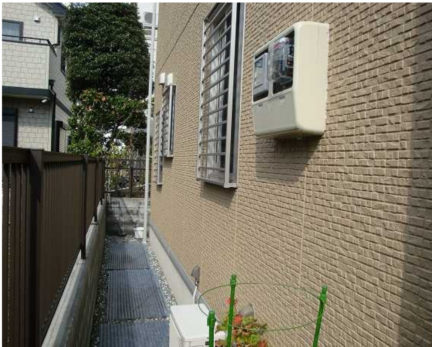
積算電力量計 (買電メーター)
