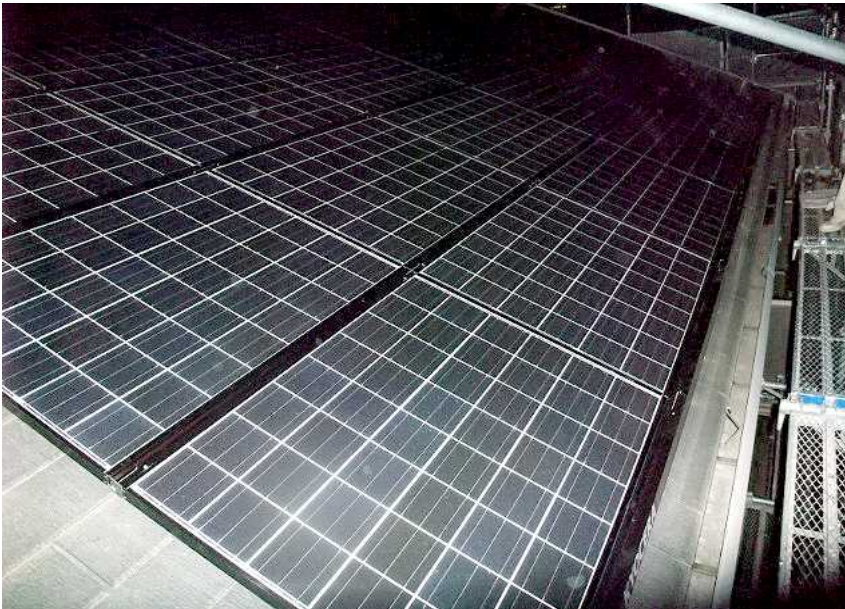
モジュール取付
