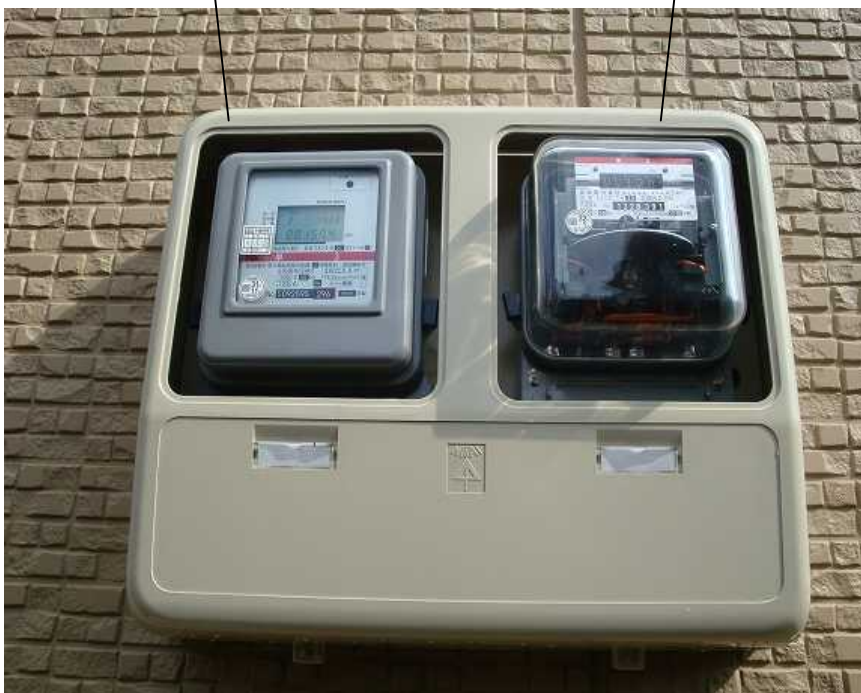
積算電力量計 (買電メーター)
